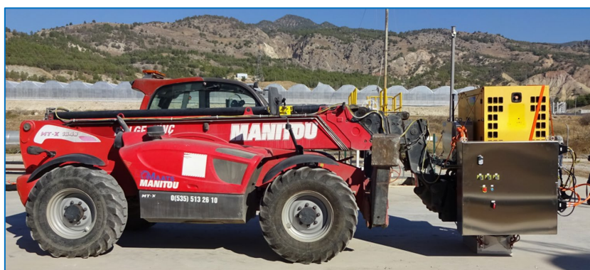
Figuur 5: Veld implementatie van de nieuwe 10kN eVibe in Kizildere op de geothermische plant.
