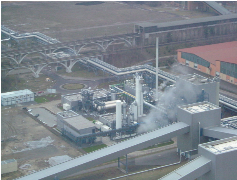
Figure 5.2 Vattenfall Schwarze Pumpe CCS Oxyfuel demo plant
